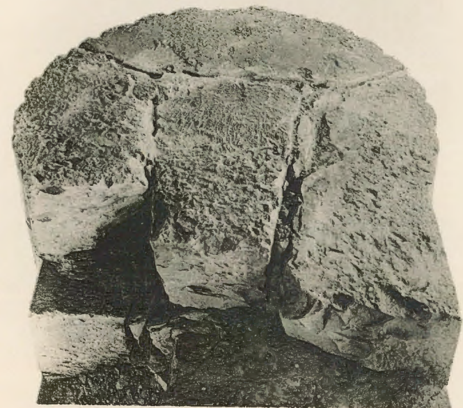
2. Appareillage des assises des colonnes fasciculées.
